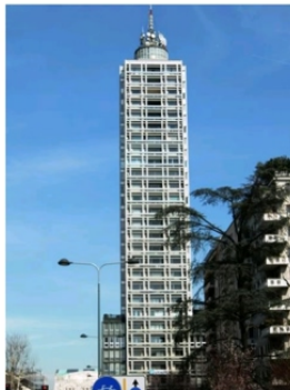
Torre Breda 1954 117mt
