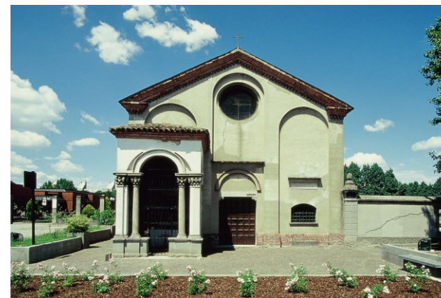
Chiesa di Santa Maria Nuova e Cappella della Madonna del Pilastrello lungo la strada provinciale 11 a Vimodrone
